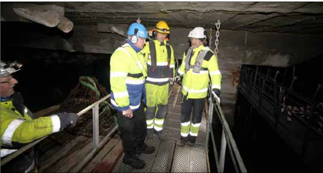
Et midlertidig hengestillas gjør det mulig å komme seg rundt under kaia.
