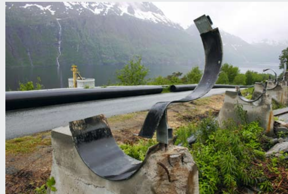
Den gamle hovedvannledningen av glassfiber er kassert - nå legges 63 cm plastrør.
